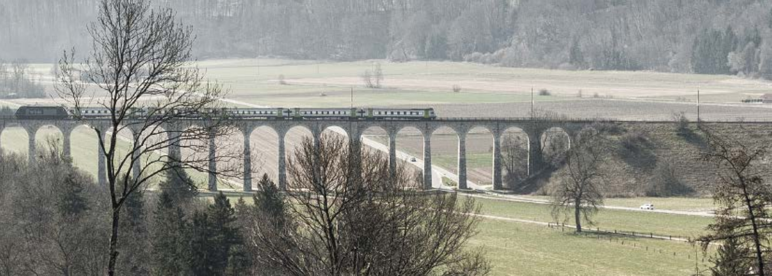
Saaneviadukt Gümminen 1901 Ferenbalm – Mühleberg
