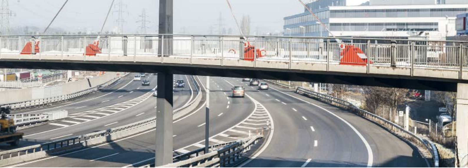
Velobrücke über die Autobahn A1 1997 Ittigen
