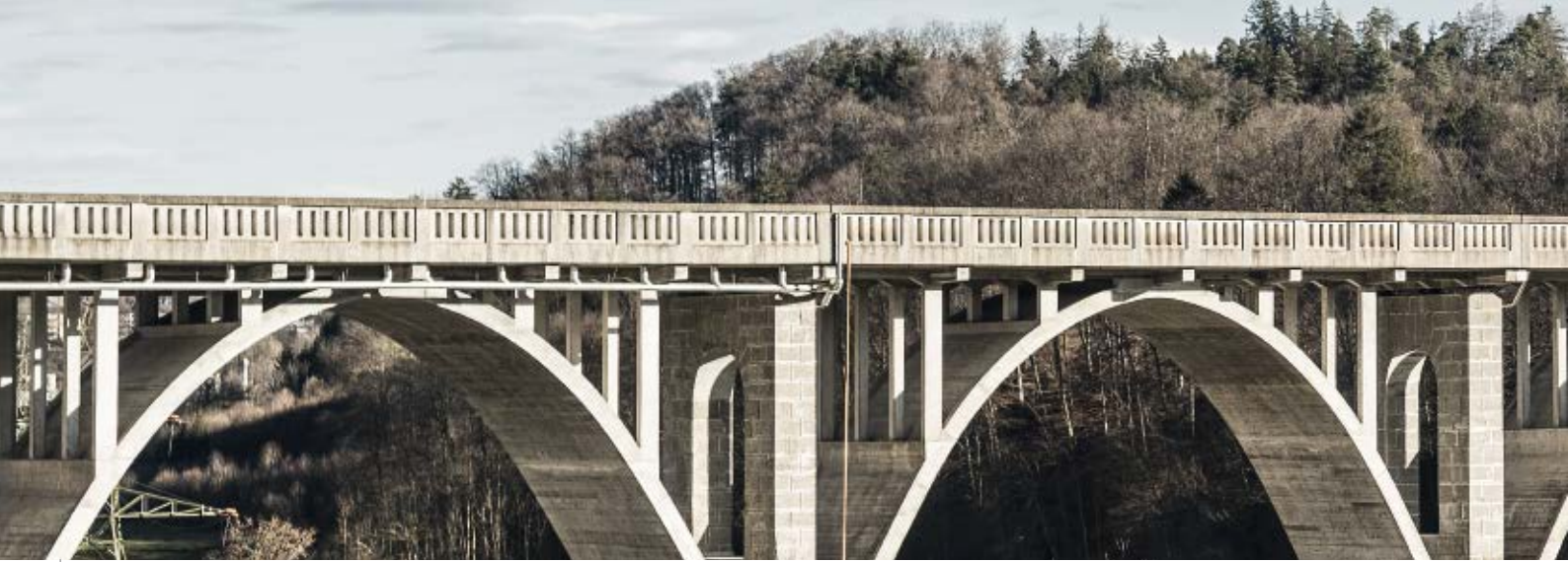
Halenbrücke 1913 Bern – Kirchlindach
