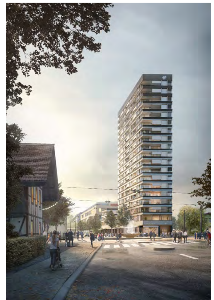
Ein Beispiel, das im Q-Team besprochen wurde, ist das Hochhausprojekt Lischenmoos in Bern. Architektur: Michael Meier und Marius Hug Architekten AG, Zürich
